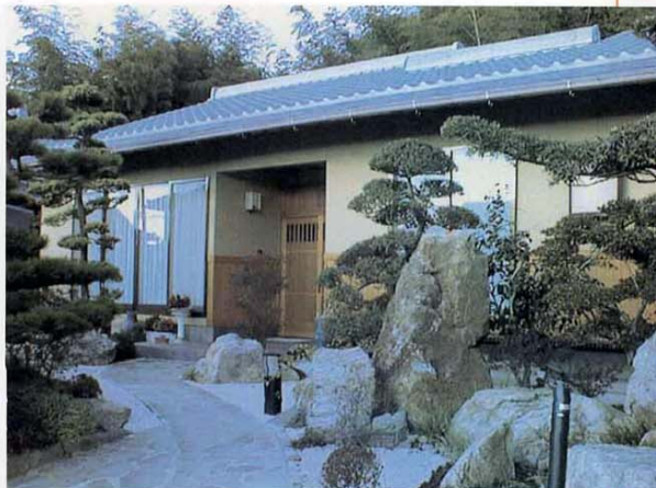
机張原の家/外觀 木造在来工法ならではの近代和風住宅の趣
