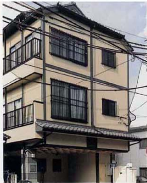
古ヶ鶴の家/外觀 敷地39坪/世帯4世帯の鉄骨造和風3階建て
