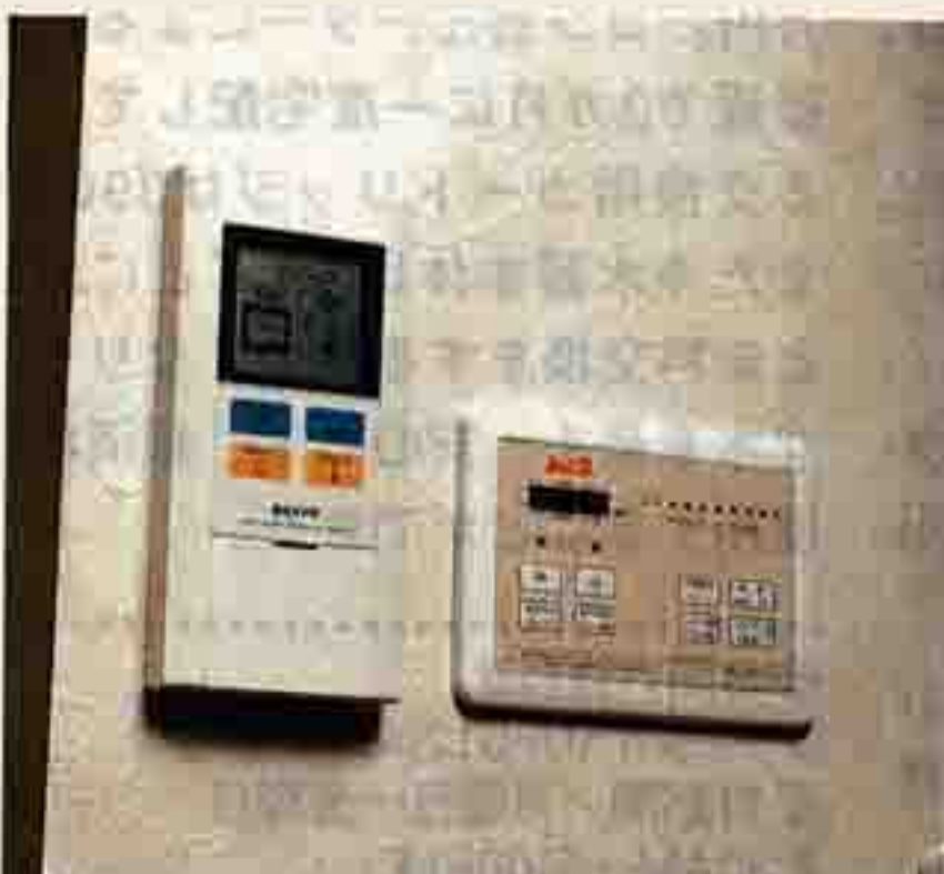
電気温水器や床暖房のコントロールパネルはまとめてキッチンに設置。操作も簡単で使い勝手が良いとのこと
