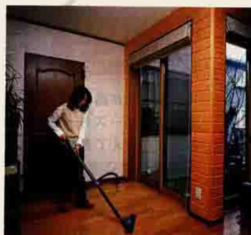
ハウスダストアレルギーだとおっしゃる奥様にとっては、屋外排気のセントラルクリーナーシステムは嬉しい設備のひとつ
